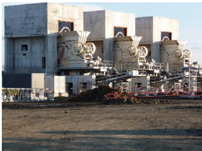
Operazione di montaggio sezione di frantumazione primaria
